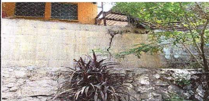
Foto 1: Reparación de muros de contención del aula multigrado.
