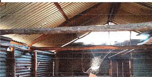
Foto 2: Reparación de cocina para nivel Primaria y Preprimaria.
