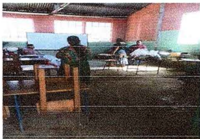
Foto 5. Colocación de piso cerámico
