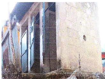
Foto 3.1: Servicios sanitarios, sustitución de puertas de metal.
